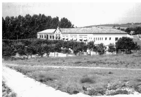
Figura 16. Edifici dels Col·legis Nous després de l'ampliació de 1965. Font: AHMMV
